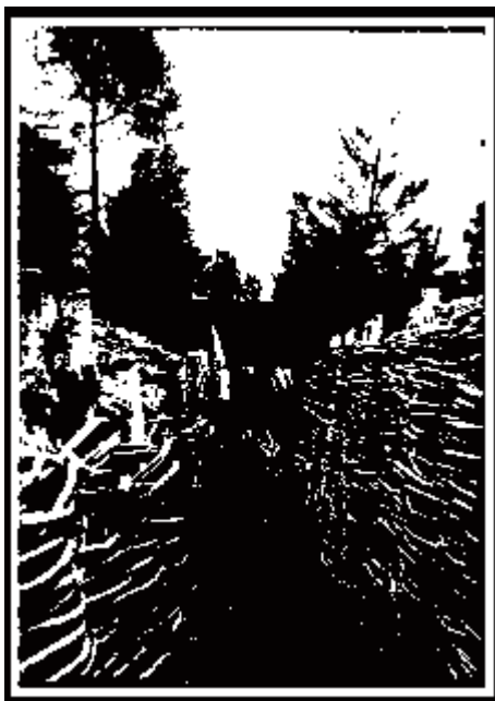
Trincea rinforzata con rami di legno , Fotografia dell'Esercito austro-ungarico 15-18 (da www.14-18.it )
