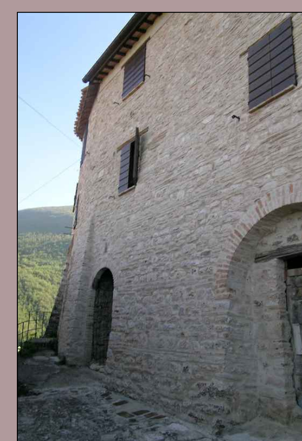
Possente edificio interno
