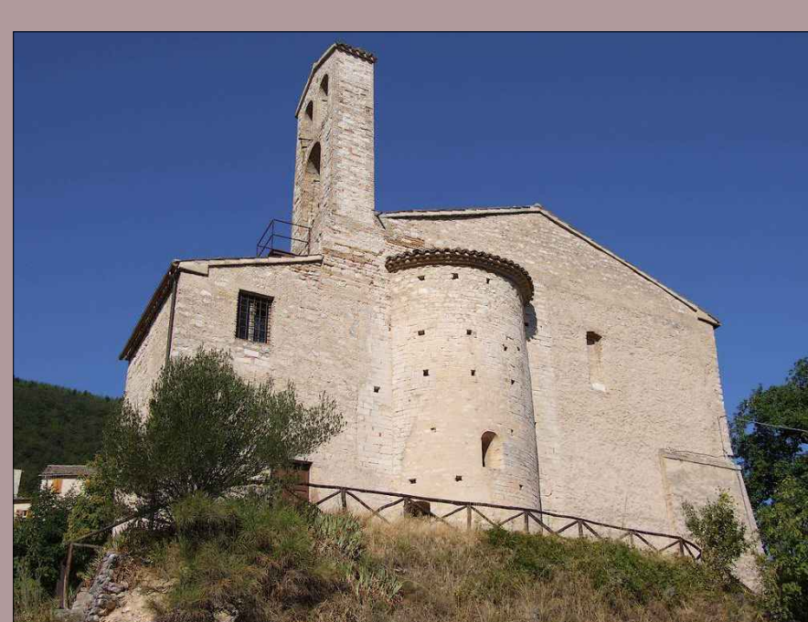
abside e campanile a vela
